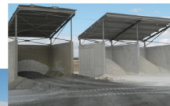
silo de clinker
