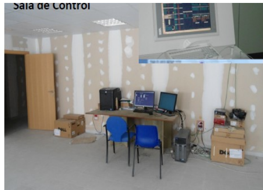
Sala de Control
